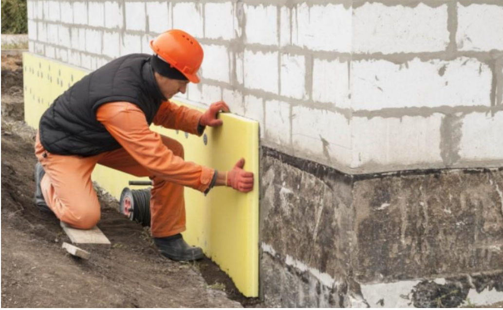
Şekil 3. Yapılarda mantolama için XPS köpük materyalinin kullanımına bir örnek [12]
