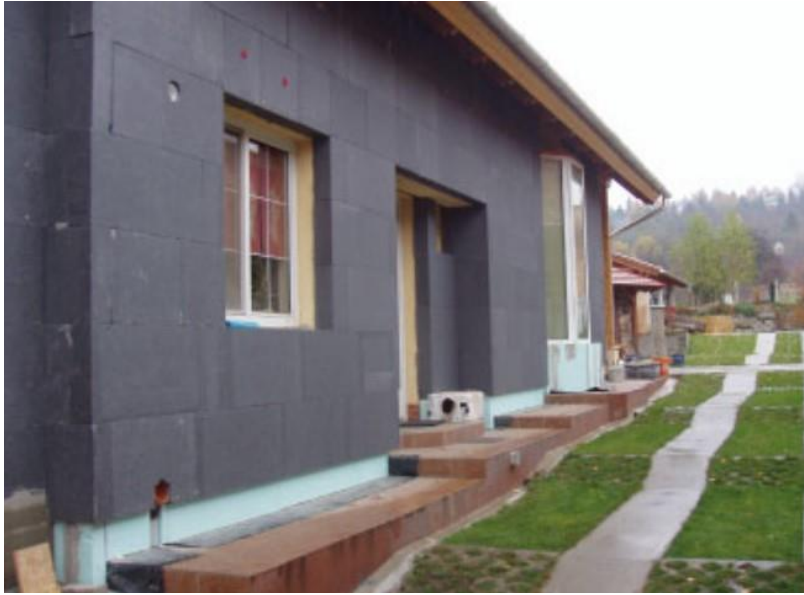
Şekil 4. EPS mantolama için uygulama örneği [13]
