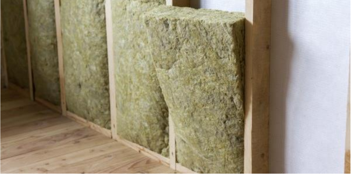
Şekil 1. Taş yünü yalıtım örneği [10]
