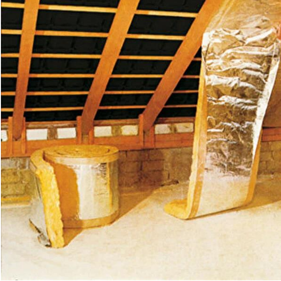
Şekil 2. Çatıya folyolu cam yünü uygulaması örneği [11]
